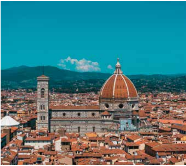
Figura 5. Filippo Brunelleschi costruiva dal 1418 al 1434 la cupola del duomo di Firenze che, accanto alla cupola di S. Pietro e del pantheon a Roma, è considerata una delle cupole in muratura più grandi del mondo (Fonte Flickr).
